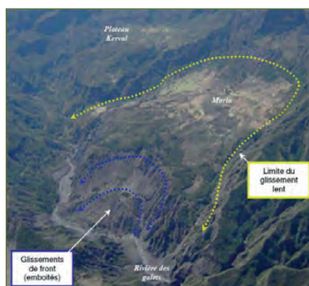
Glissement de Marla, cirque de Mafate. Source BRGM.
