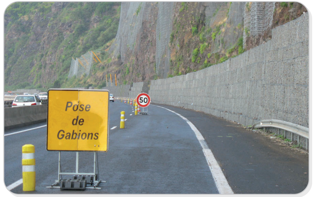
Pose de gabions sur la route du littoral - La Possession (2008) www.aquaterra-solutions.fr
