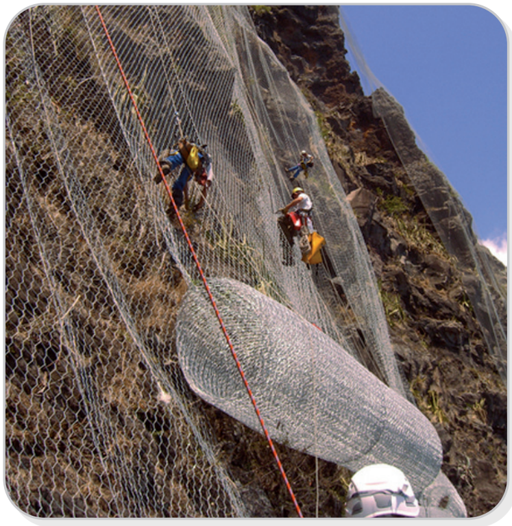
Pose de filets de protection sur la route du littoral La Possession (2006) www.sogea.re
