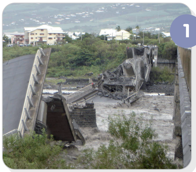
Pont de la rivière Saint-Etienne suite à la crue de la rivière - Saint-Louis (2007) - DEAL
