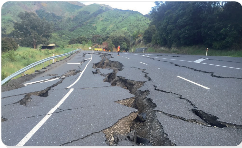
Après le séisme - Nouvelle-Zélande (2016) - Imgur.com
